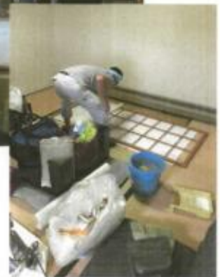
和室 障子紙施工中
