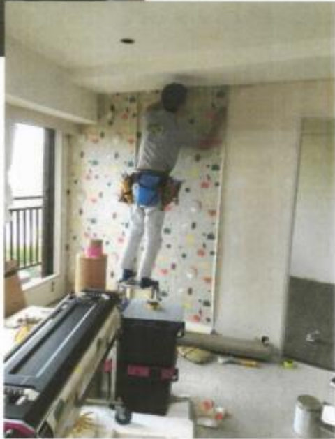
クロス施工 (リビング一面FE3956施工)
